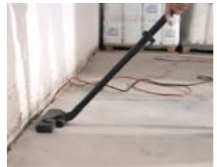
Σκούπισμα των υπολειμμάτων και της σκόνης με ηλεκτρική σκούπα υψηλής απορροφητικότητας
