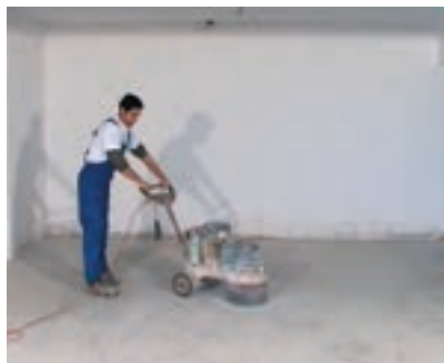
Σχολαστικό τρίψιμο της επιφάνειας με μηχανή μωσαϊκού
