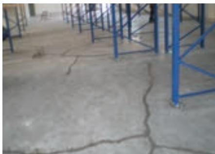
Οι ενδεχόμενες ρωγμές στο υπόστρωμα, διευρύνονται σε τομή τουλάχιστον 10x10mm, κόβονται εγκαρσίως ανά 30cm, και στοκάρονται με Epoxol® Putty σε αναλογία 2A:1B
